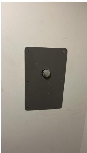
Bouton extérieur de la chasse d'eau
